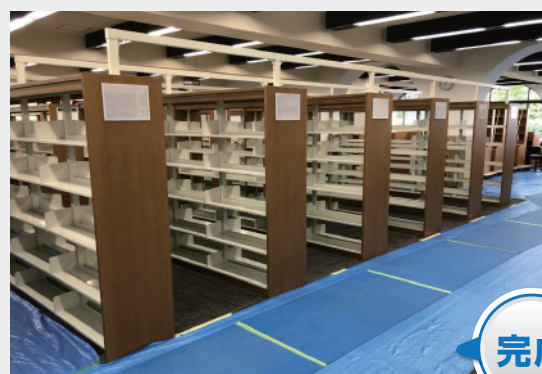
書架の棚板取り付け
