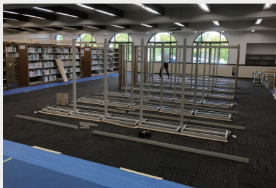
書架の骨組み組み立て①
