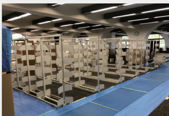
書架の骨組み組み立て②
