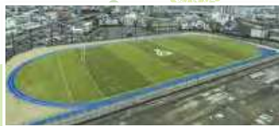
新グラウンド(写真下は観覧席エリアに。現在建設中)
