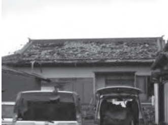
図 1-3 C：著しい劣化状態の瓦
