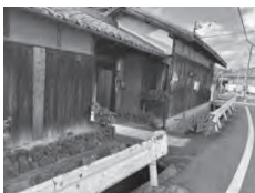
写真9 水路がある民家1
