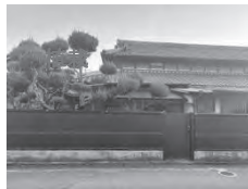
写真8 庭がある民家2
