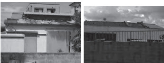
図 2-1 A：良好な状態の鋼板製屋根（左図）
