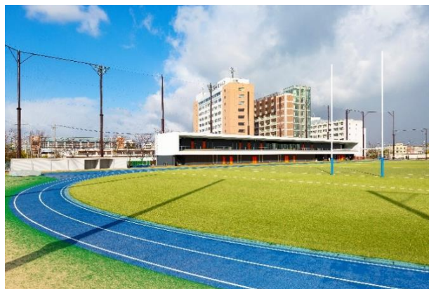
全天候型400mトラックを備えた東グラウンド
