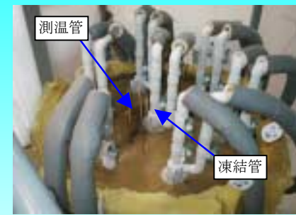
チルド・ブロック室内試験状況
