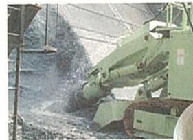
ダム下流側より軟石トンネル掘削機（ロータリーヘッダ）により堤体掘削
