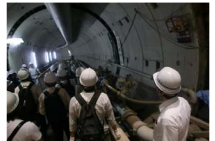
地下河川工事現場の見学
