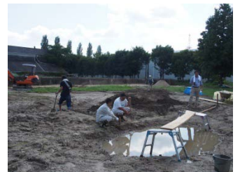
土木工事の様子
