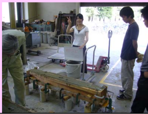
コンクリートの 打設完了！
