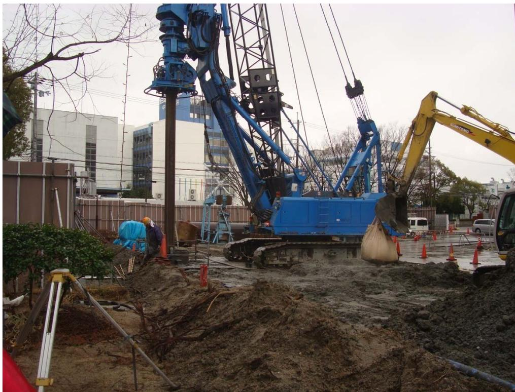
場所打ち杭の大きさは、直径1.5m程度、深さ20数mですので、そのための穴を掘っています。穴の上部には、崩落を防ぐためのケーシングがあります。作業中にクレーンが倒れる事故がないよう、地盤を強くして（地盤改良）おり、その上に鉄板を敷いています。
