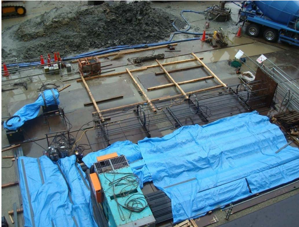
杭の中には骨となる鉄筋が入っています。大学の建設工事エリアは比較的広いため、工事エリア内で鉄筋かごを組んでいます。長さ方向の鉄筋が『主筋』と呼ばれます。その周りを『あばら筋（帯筋）』で囲み、円柱の杭の骨組みが出来上がります。
