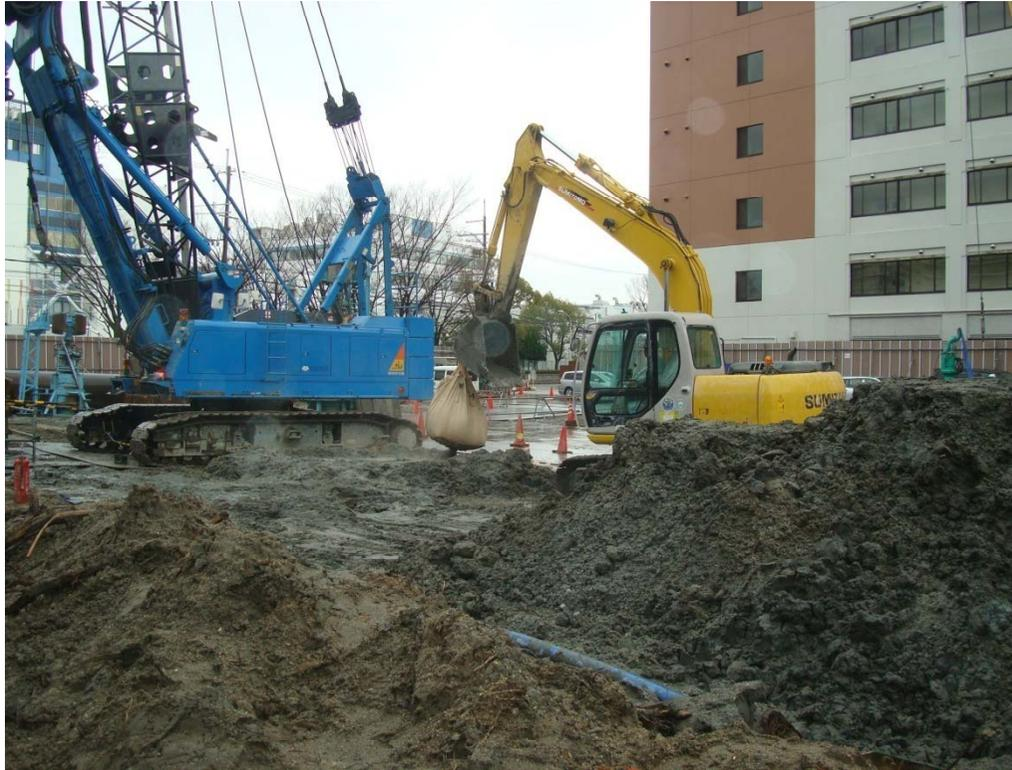
この黄色のショベルカーは、掘削で出た土にセメントを混ぜています。掘削で出た土は水などを含み、柔らかい状態なので、セメントを混ぜることで固くしています。トラックで最終処分場まで運搬できるようにするためです。
