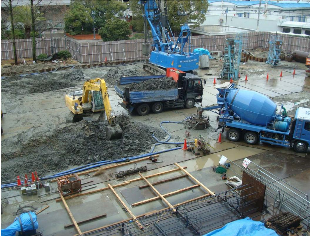
コンクリートミキサー車からフレッシュなコンクリートが入れられます（打設）。もちろん、鉄筋がすでに入った状態です。杭1本の打設を完了するためにはコンクリートミキサー車が7台程度必要です。
