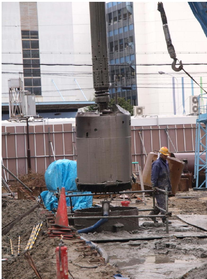
掘削機の先端には、土を削るためのカッターと掘った土を収納する部分があります。掘削した土は引き上げられます。
