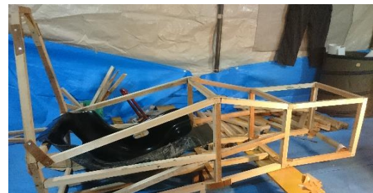
図4 SR-08 モックアップ (未完成)
